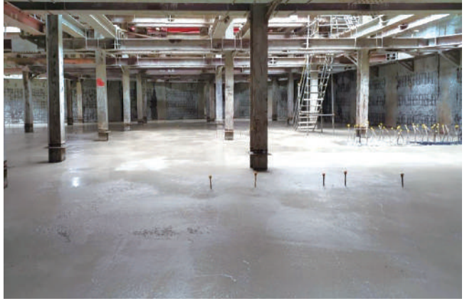
大底澆置混凝土
