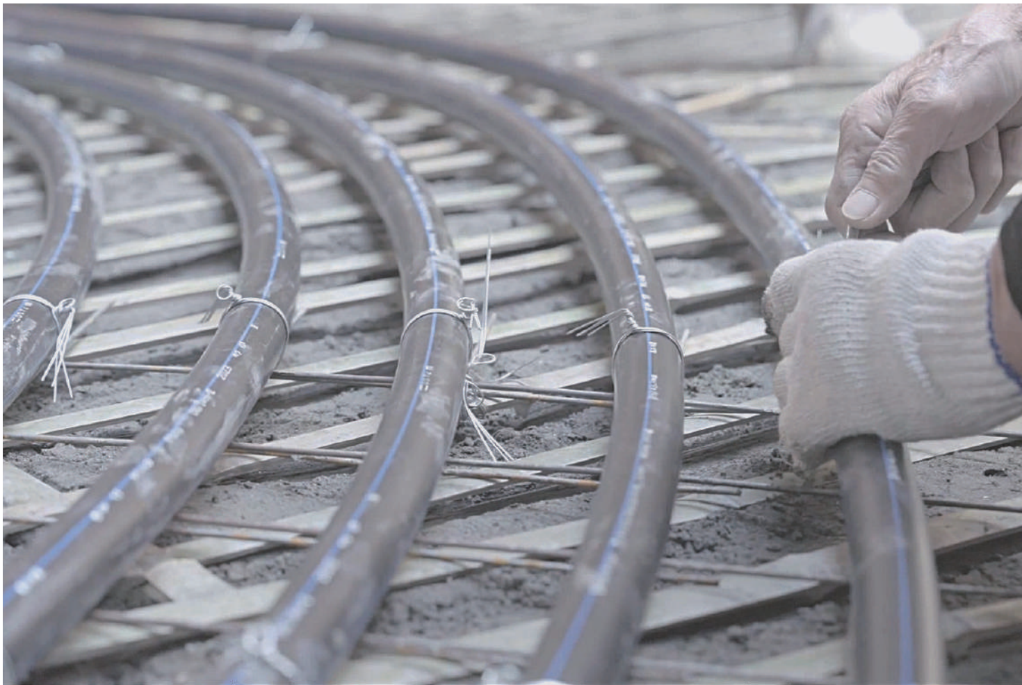
工人將管線固定於鋼絲網上
