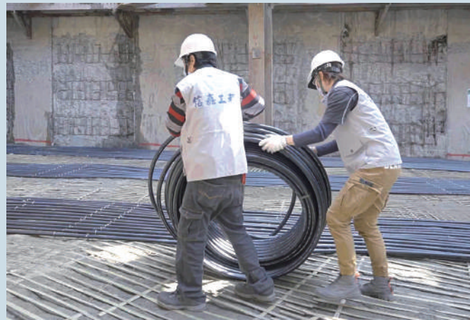
工人正滾動管線佈線
