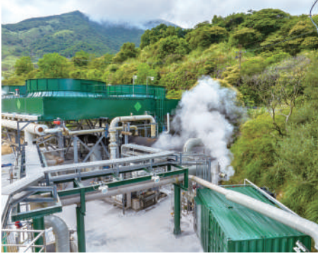
四磺子坪先導地熱電廠廠房設施（許釗滂攝）
